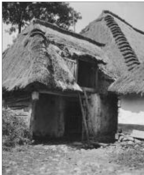
Obr. 17: Cerovo 1953, seník vikýř - výlet, chlévy připojené souvisle s obydlím, došková střecha s vikýřem, čp neurčeno, ič 33104. Pozůstalost Karla Chotka, soukromé vlastnictví rodiny Chotkovy
